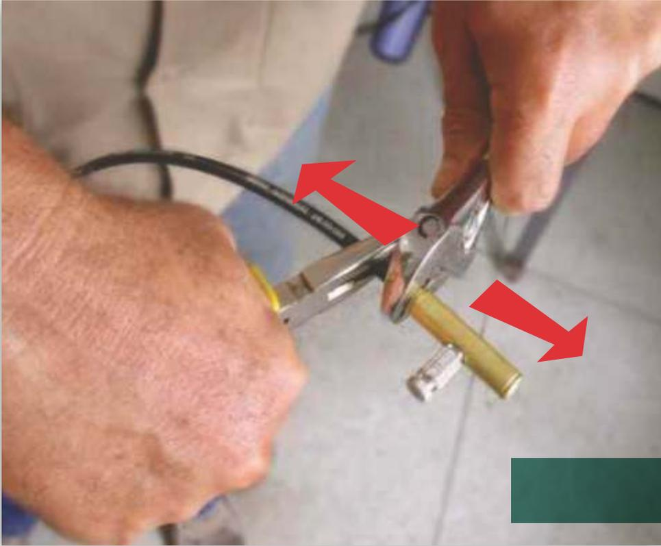
Sistema de Engate Rápido. Para o desengate fácil do tubo da conexão, execute conforme o procedimento ao lado
