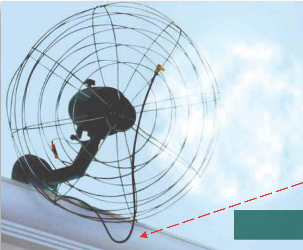
Deixe sempre uma folga entre a linha fixada na parede e o ventilador para não prejudicar a oscilação
