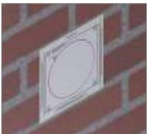
Utilize o gabarito para marcar o local onde será feita a furação para a passagem do tubo e para a fixação do bloco motor.
